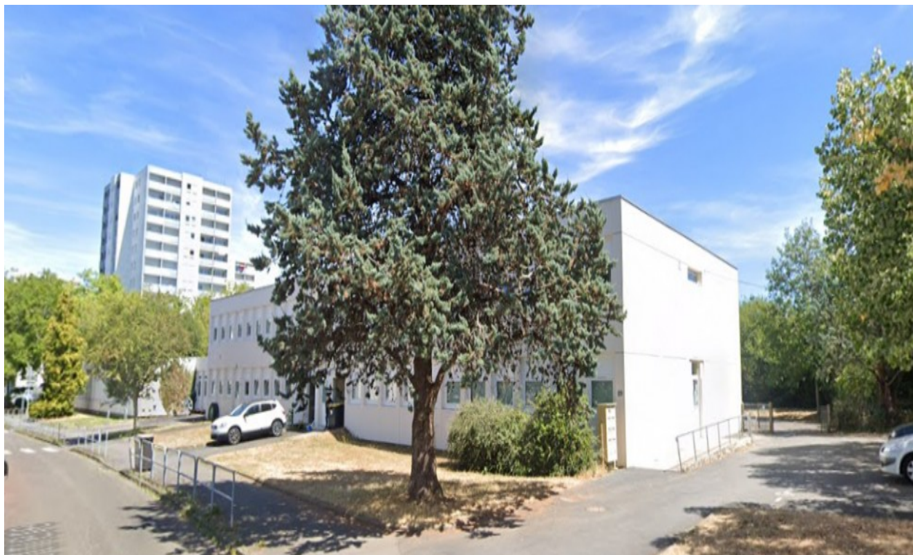
Petite porte d'accès pour les locaux de l'UNAFAM, 48 rue de Charrière – Vue Google street view
